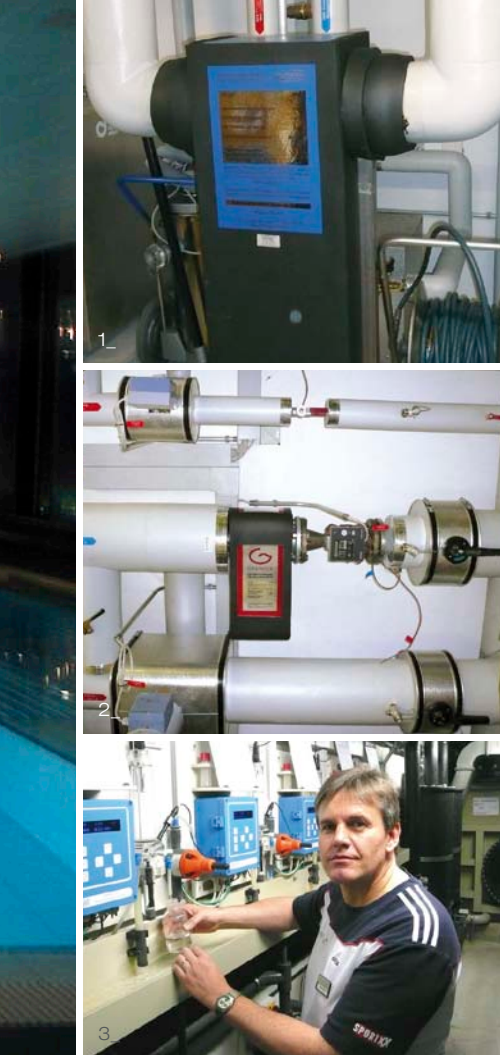
1 - 2_ Die Installation der Wasserbelebungsanlage ist recht einfach.
